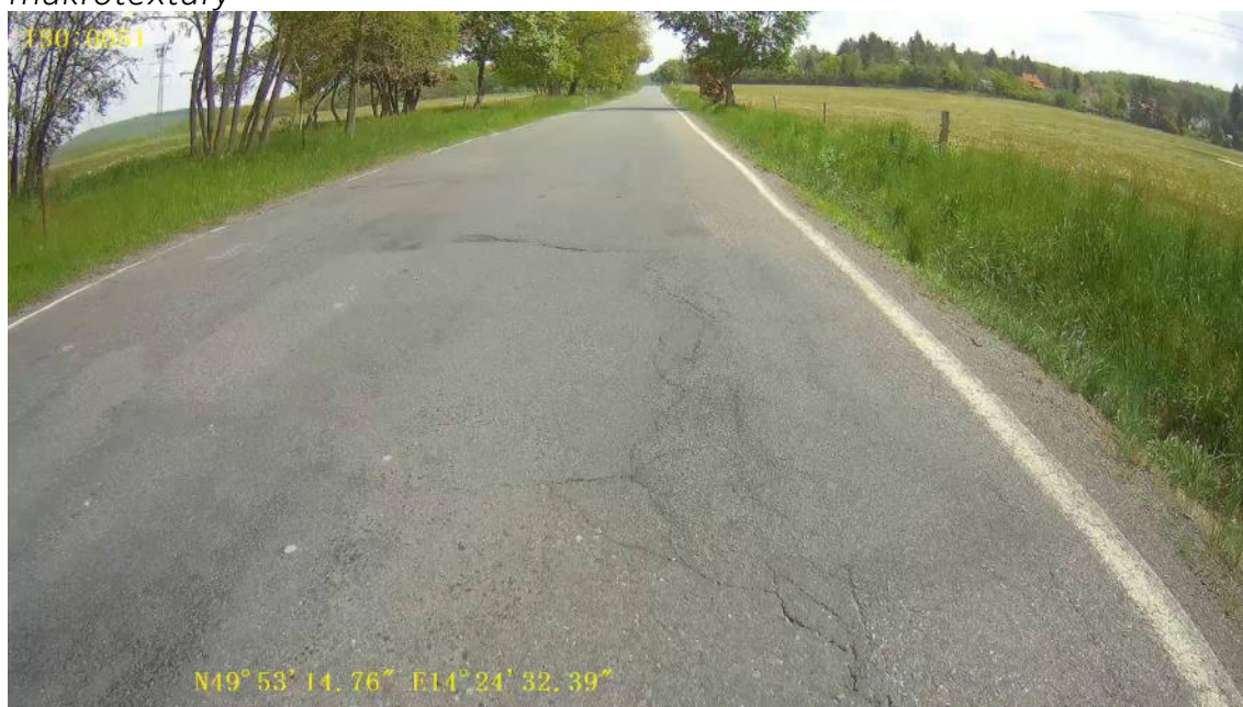
Obrázek A. 22 km 1.800, podélné a příčné trhliny rozvětvené, ztráta makrotextury
