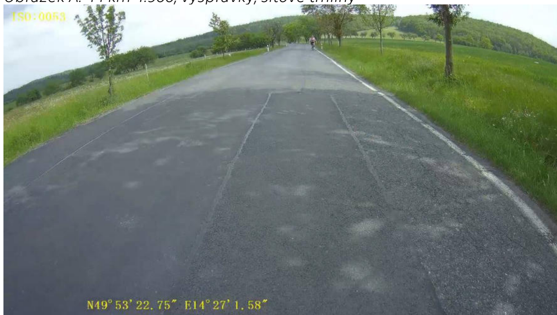
Obrázek A. 44 km 4.900, vysprávký, síťové trhliny
