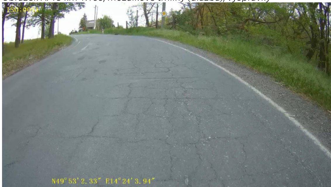
Obrázek A. 16 km 1.200, podélná trhlna úzká, vysprávkvy
