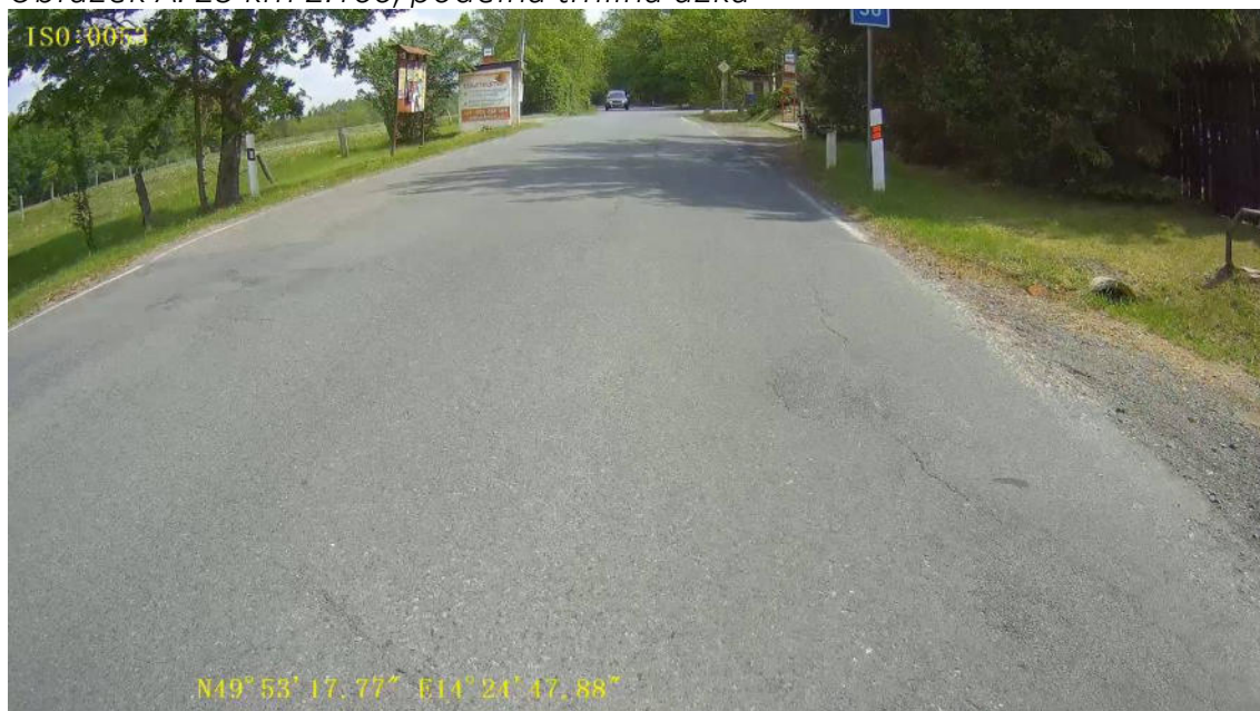
Obrázek A. 26 km 2.200, podélné trhliny široké, vysprávký
