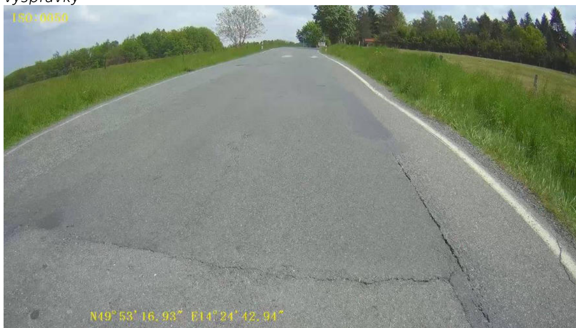
Obrázek A. 24 km 2.000, podélná trhlina široká, příčná trhlina úzká, vysprávkky
