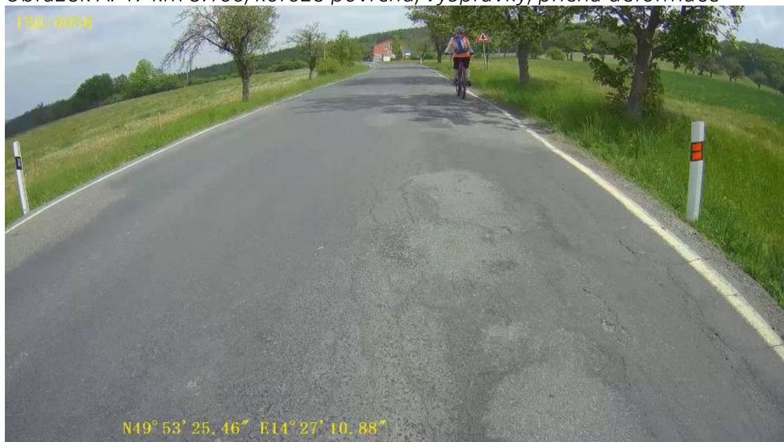
Obrázek A. 48 km 5.200, vysprávkky, koroze povrchu
