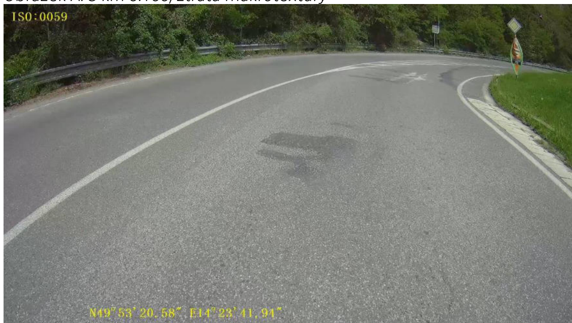
Obrázek A. 4 km 0.125, podélná trhlina široká
