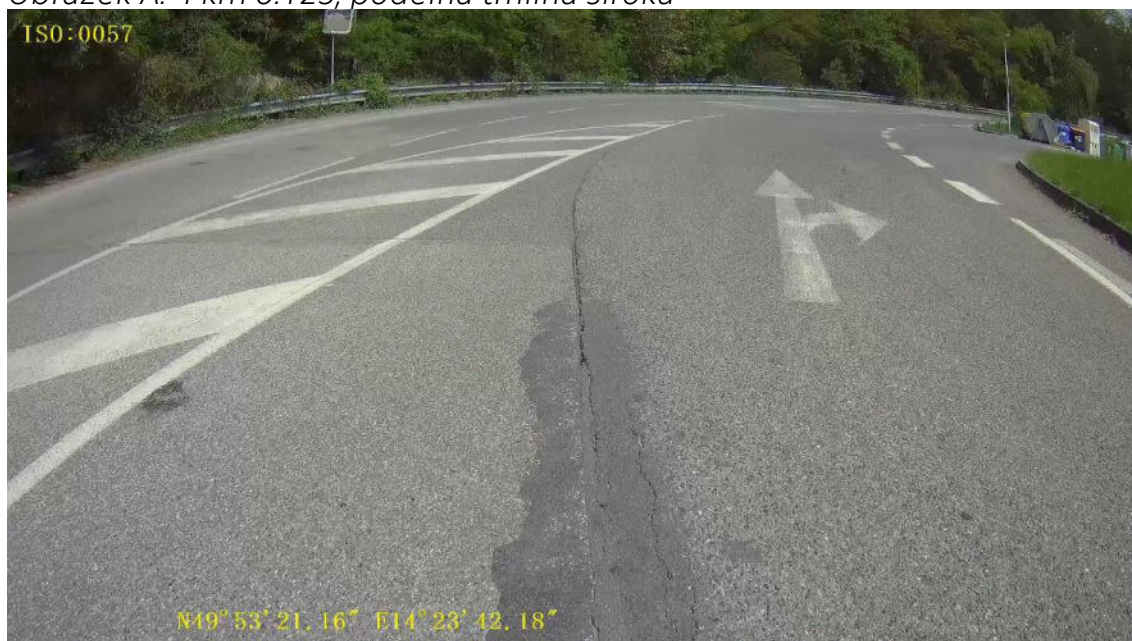
Obrázek A. 4 km 0.125, podélná trhlina široká
