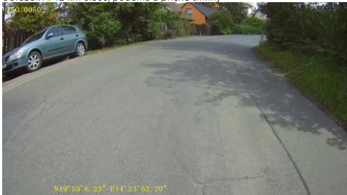
Obrázek A. 12 km 0.800, podélná a příčné trhliny
