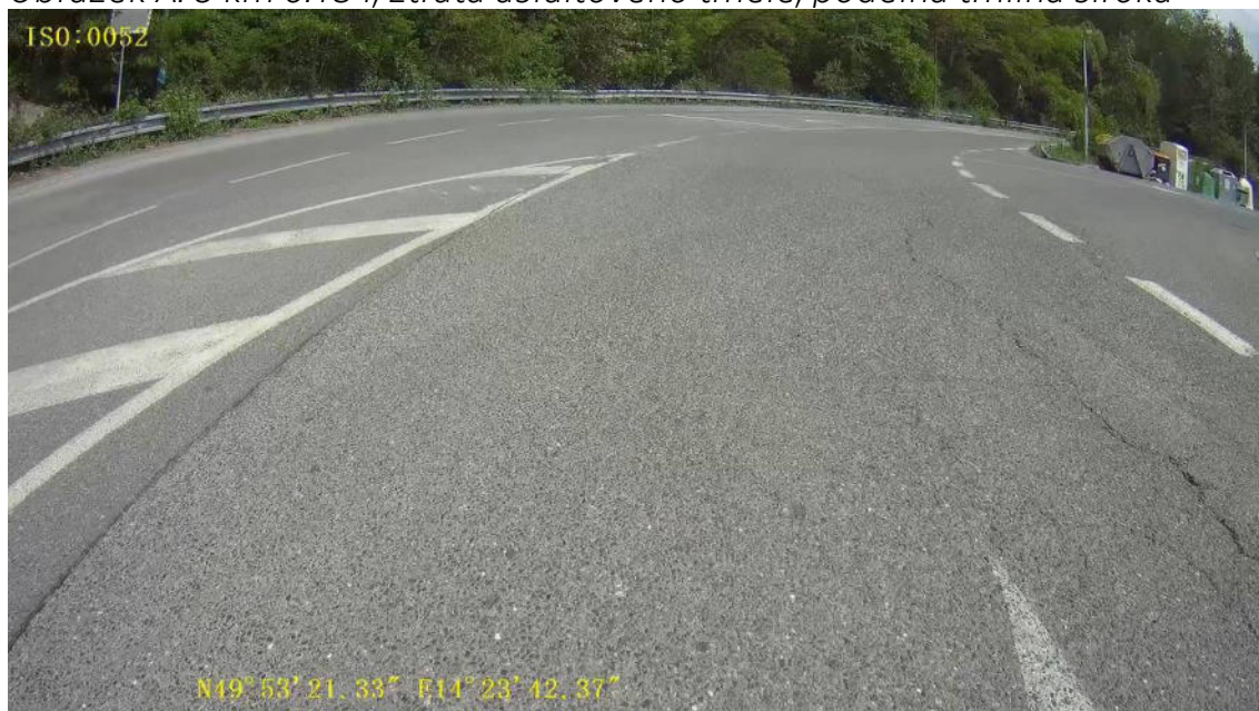
Obrázek A. 6 km 0.150, ztráta asfaltového tmele
