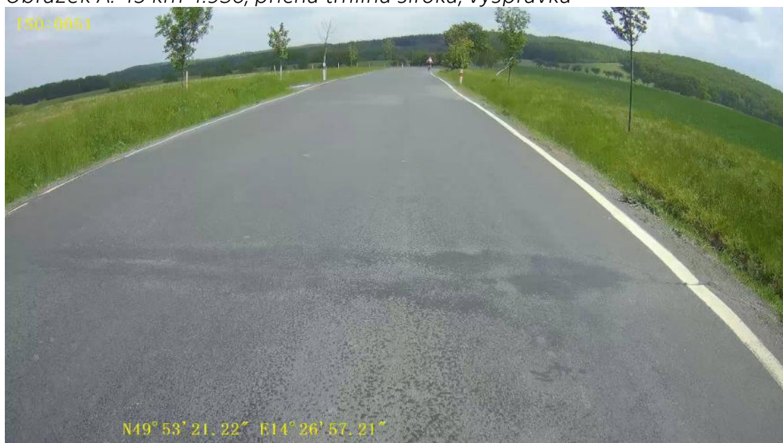
Obrázek A. 46 km 5.000, koroze povrchu, vysprávky, příčná deformace, síťové trhliny
