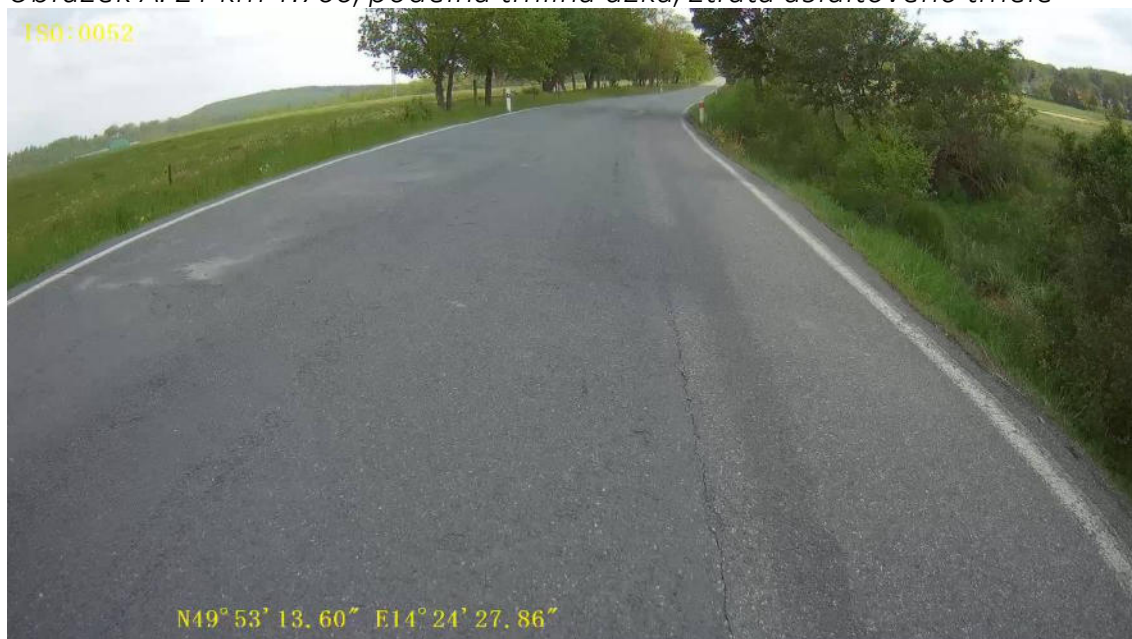
Obrázek A. 22 km 1.800, podélné a příčné trhliny rozvětvené, ztráta makrotextury
