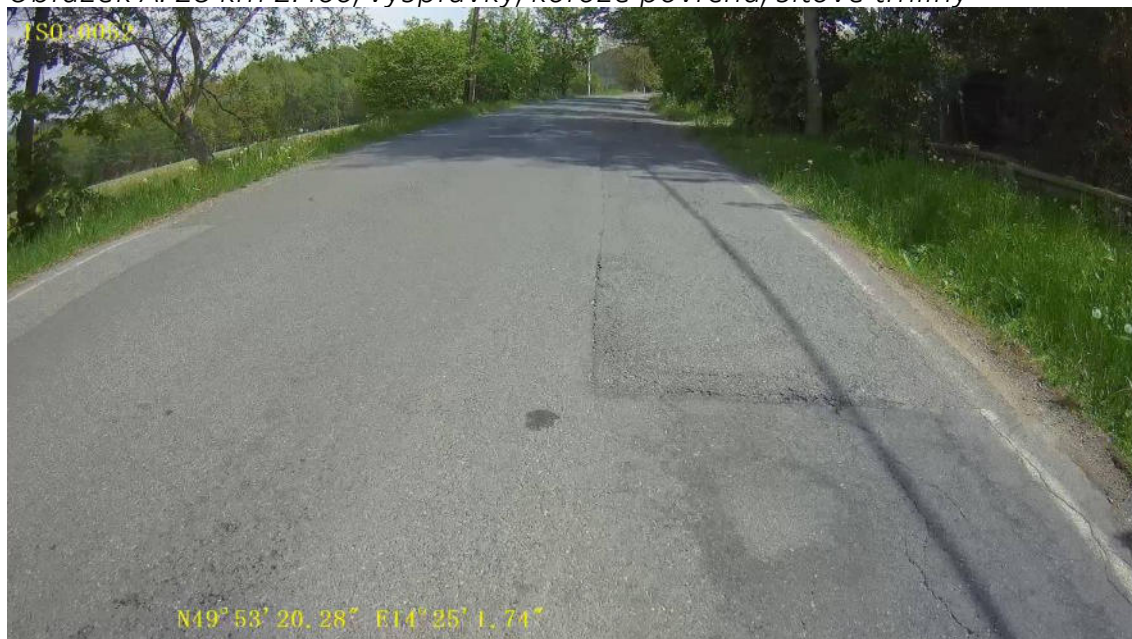
Obrázek A. 28 km 2.400, vysprávkky, koroze povrchu, síťové trhliny
