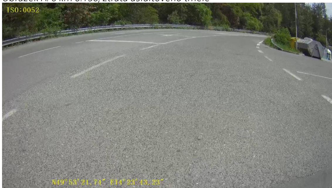
Obrázek A. 6 km 0.150, ztráta asfaltového tmele
