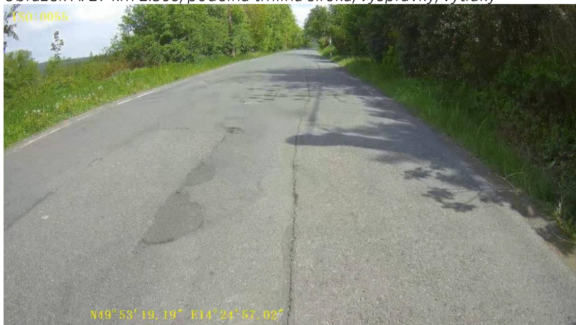
Obrázek A. 28 km 2.400, vysprávkky, koroze povrchu, síťové trhliny
