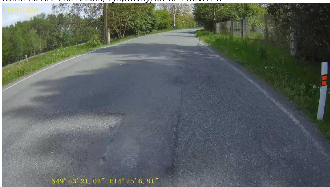
Obrázek A. 30 km 2.600, koroze povrchu, vysprávkvy, příčné trhliny rozvětvené
