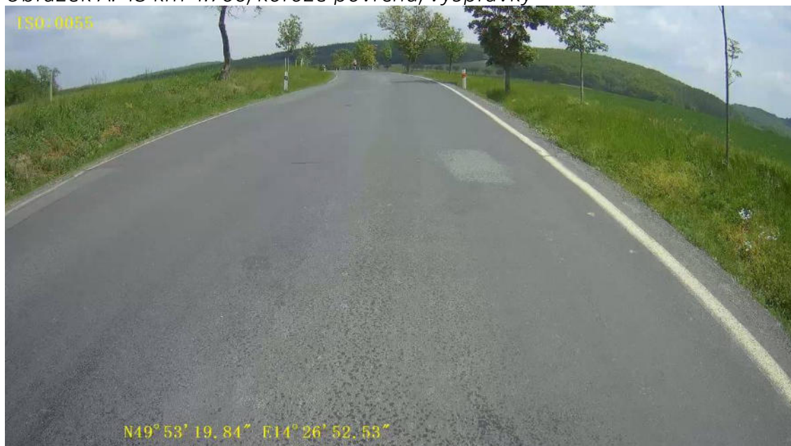
Obrázek A. 44 km 4.900, vysprávký, síťové trhliny
