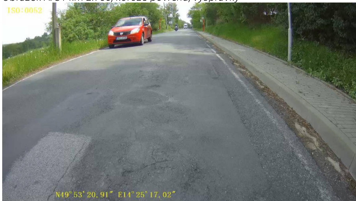
Obrázek A. 32 km 2.800, síťové trhliny, olamování okrajů vozovky
