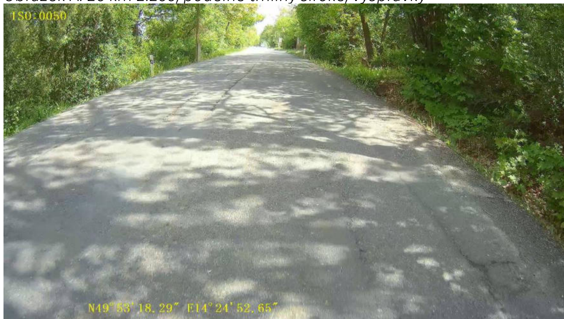
Obrázek A. 26 km 2.200, podélné trhliny široké, vysprávký
