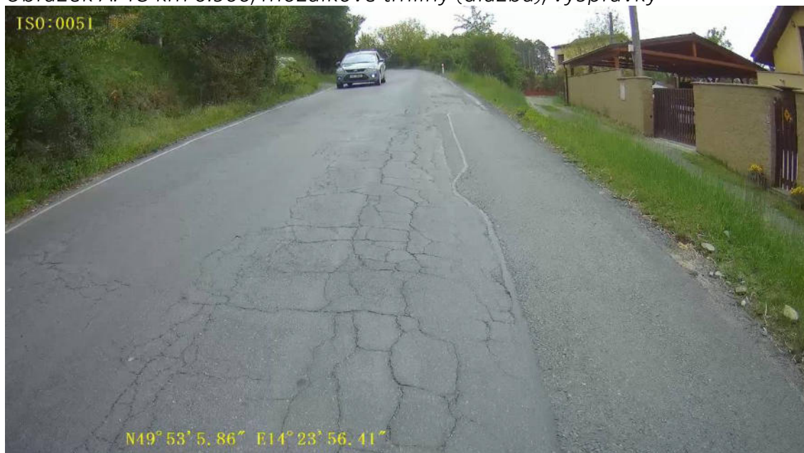
Obrázek A. 14 km 1.000, mozaikové trhliny (dlažba), vysprávk
