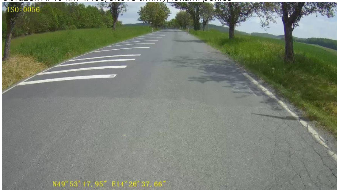
Obrázek A. 40 km 4.400, síťové trhliny, lokální pokles
