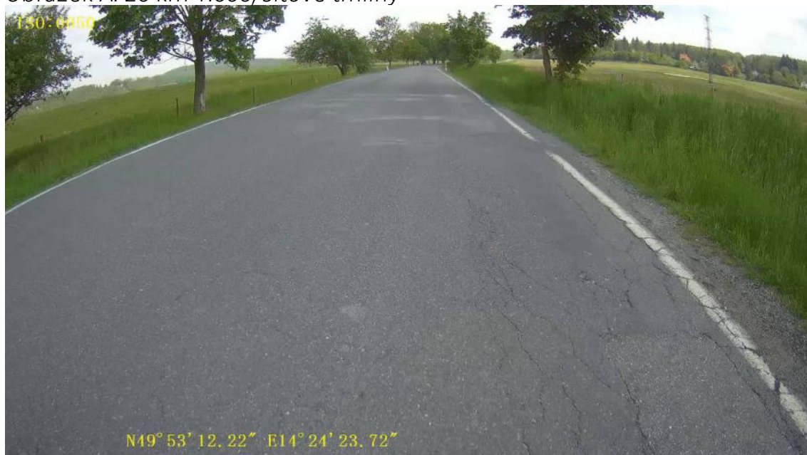
Obrázek A. 20 km 1.600, síťové trhliny
