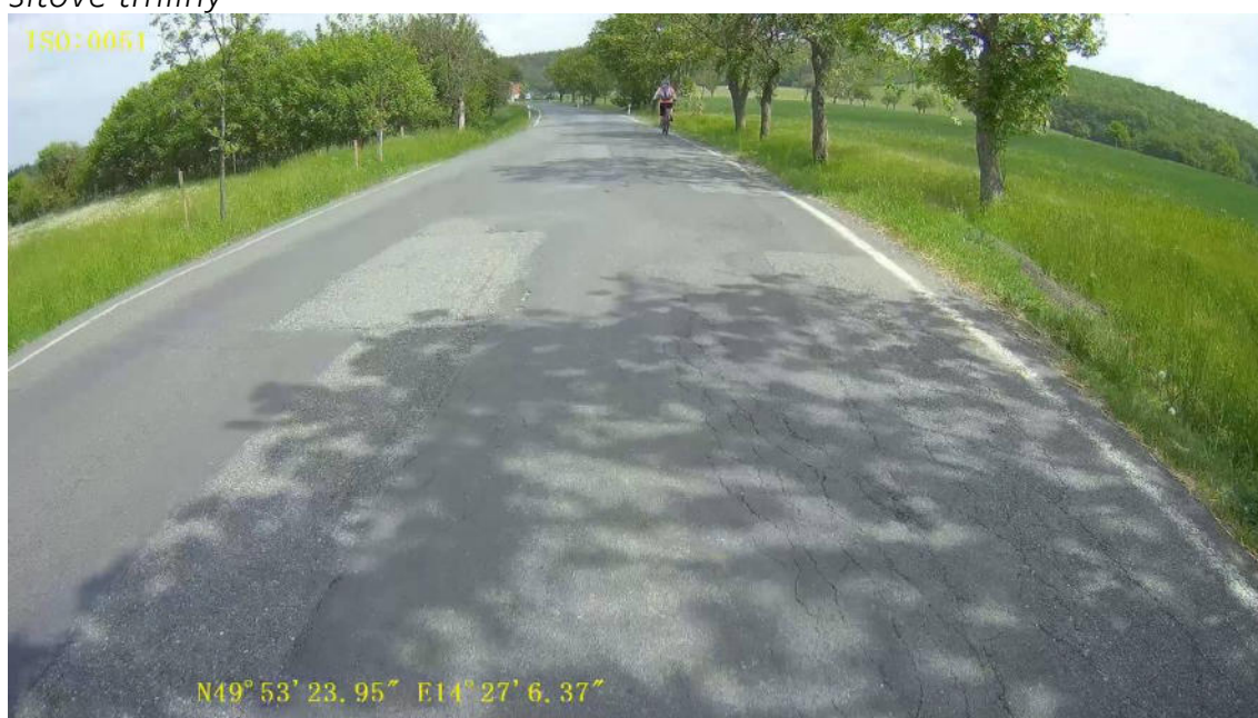
Obrázek A. 46 km 5.000, koroze povrchu, vysprávky, příčná deformace, síťové trhliny
