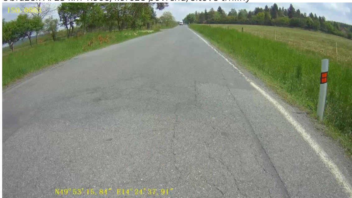
Obrázek A. 24 km 2.000, podélná trhlina široká, příčná trhlina úzká, vysprávkky
