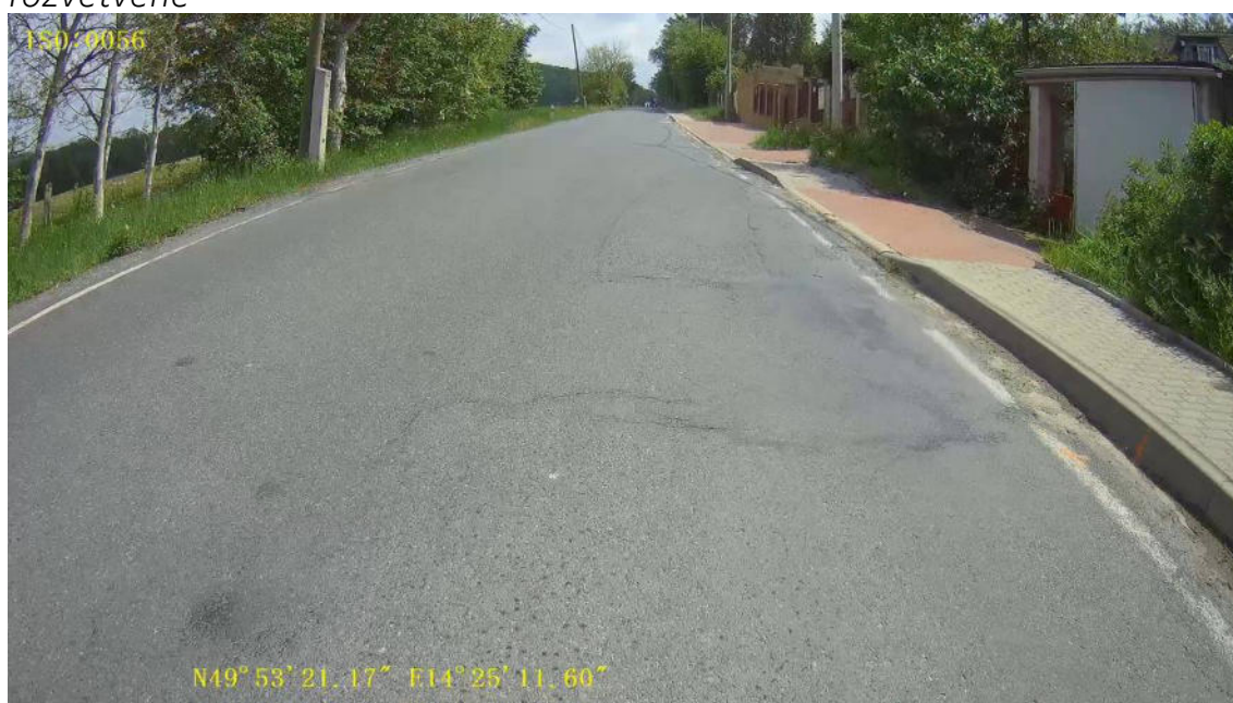
Obrázek A. 30 km 2.600, koroze povrchu, vysprávkvy, příčné trhliny rozvětvené
