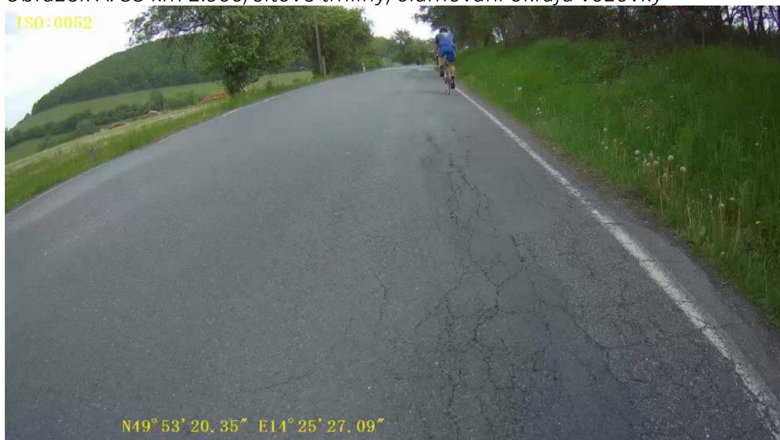
Obrázek A. 34 km 3.000, síťové trhliny, olamování okrajů vozovky
