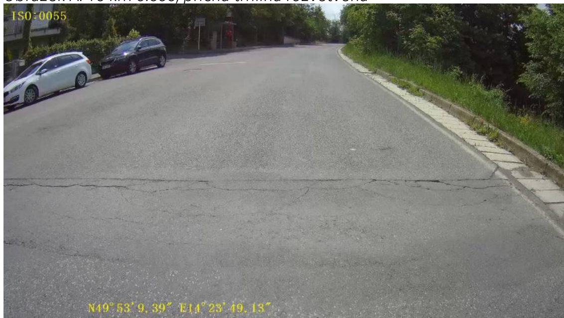
Obrázek A. 10 km 0.600, příčná trhлина rozvětvená
