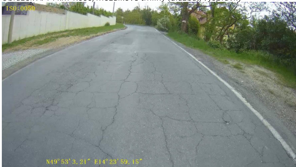
Obrázek A. 14 km 1.000, mozaikové trhliny (dlažba), vysprávk
