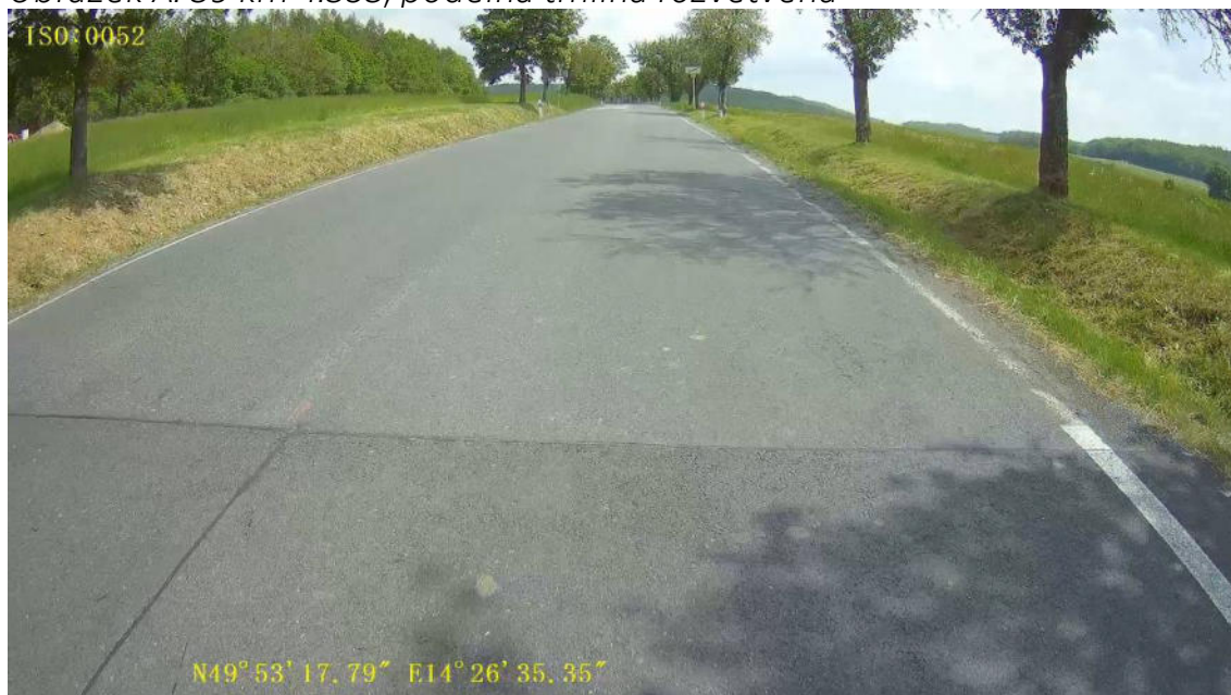
Obrázek A. 40 km 4.400, síťové trhliny, lokální pokles
