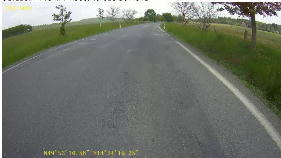
Obrázek A. 20 km 1.600, síťové trhliny
