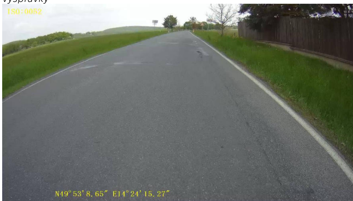
Obrázek A. 18 km 1.400, podélná trhlina úzká, ztráta asfaltového tmele, vysprávkvy
