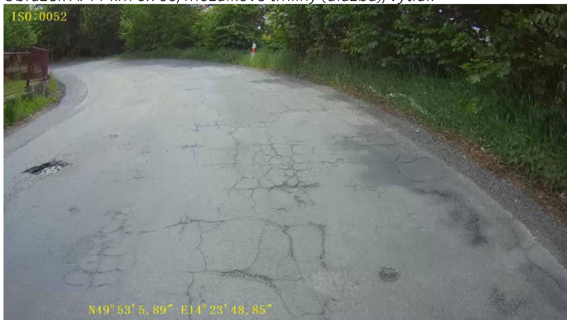
Obrázek A. 12 km 0.800, podélná a příčné trhliny
