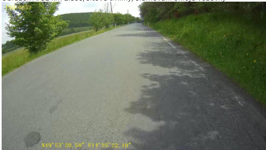
Obrázek A. 32 km 2.800, síťové trhliny, olamování okrajů vozovky
